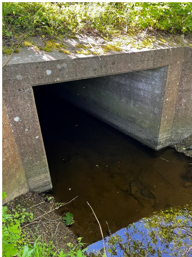
Figur 3-13 - St. 6800. Udløbet fra vejbroen ved Ringstedvej.
